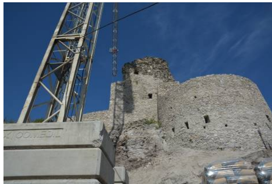
3. A torony keleti nézete az építkezés közben
