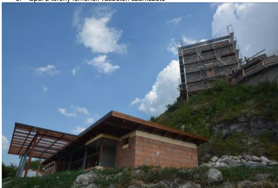
6. Épül a torony és a fogadó épület
