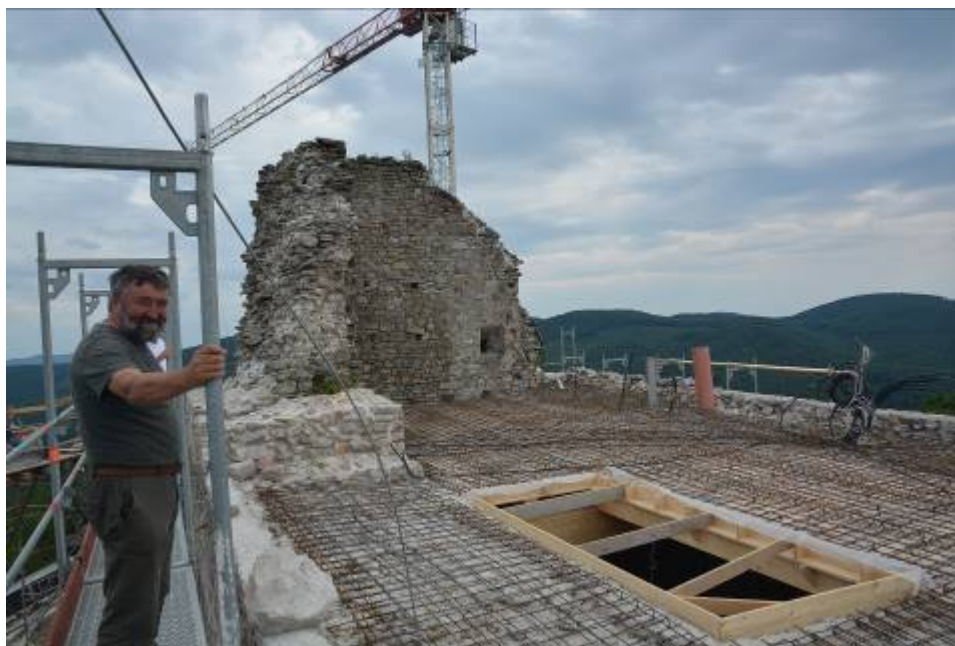
5. Épül a torony fémének vasbeton szerkezete
