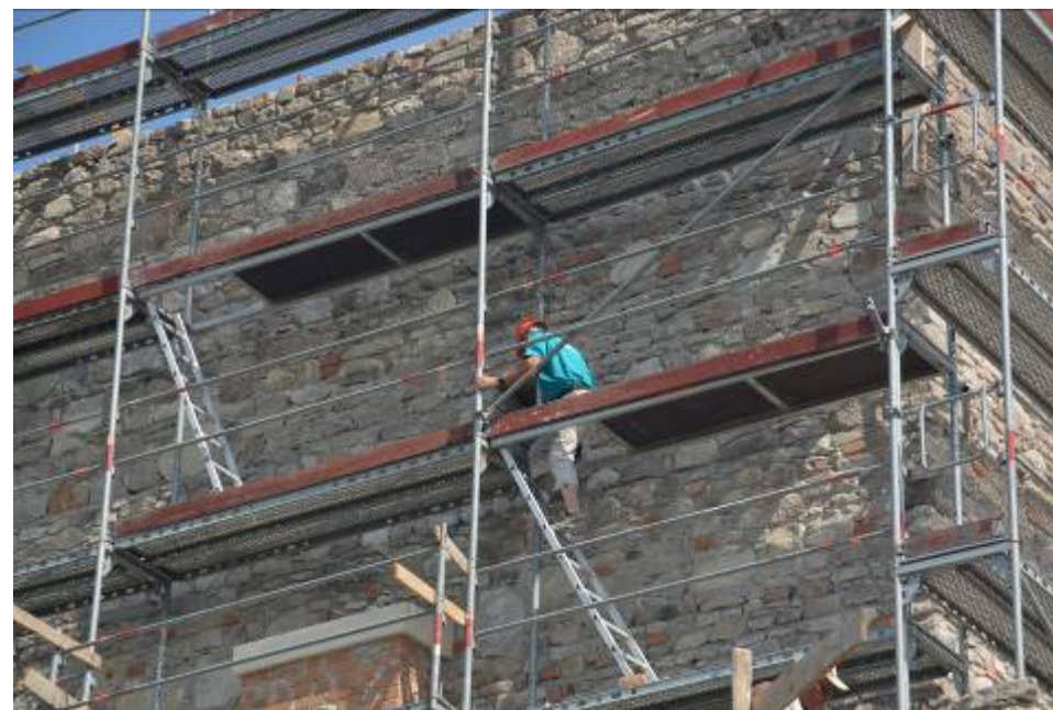
7. Az épülő új falszerkezet
