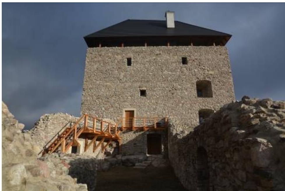
17. A helyreállított torony a Felső-vár udvaráról nézve
