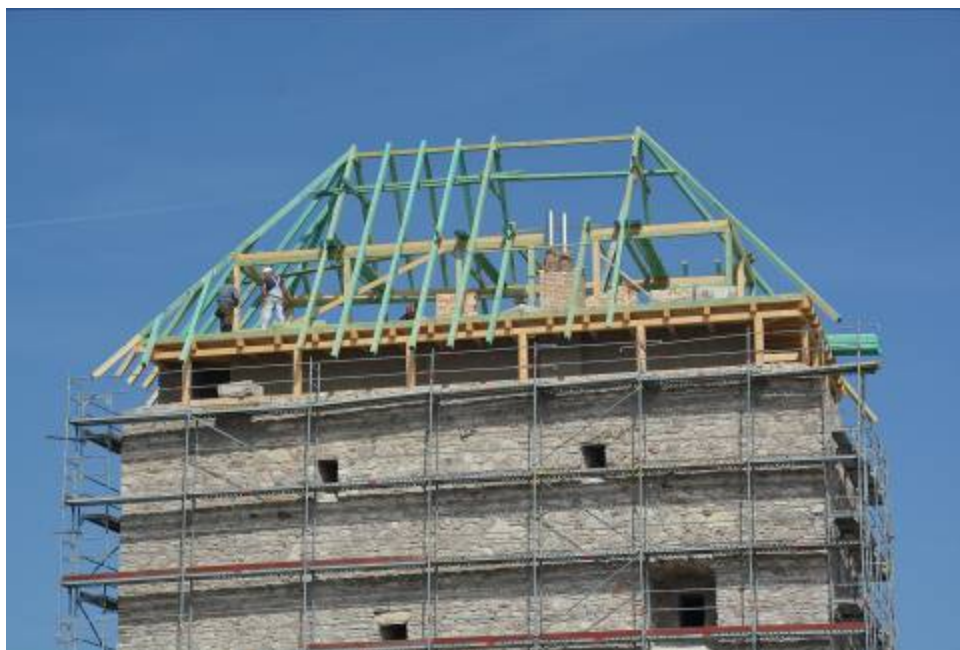
9. Épül a torony tetőszerkezete
