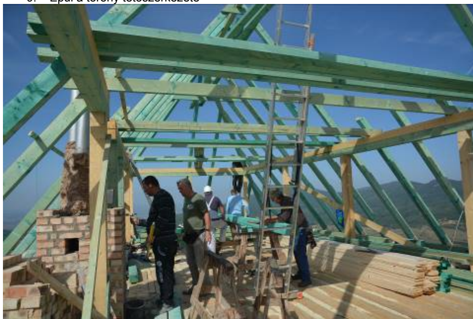
10. A tetőszerkezet építése
